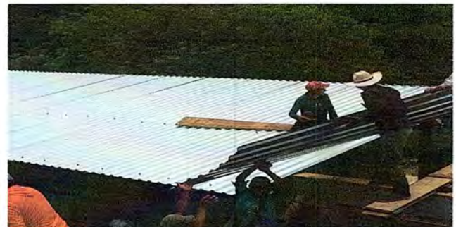
Foto 4: Instalacion de techo.
