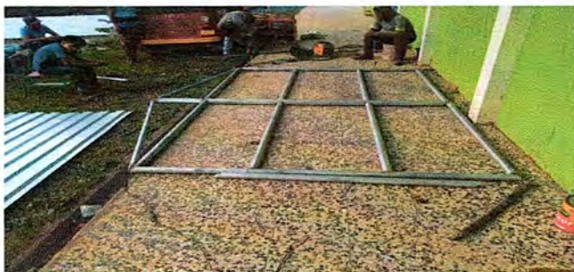
Foto 5: Reparacion de Porton principal
