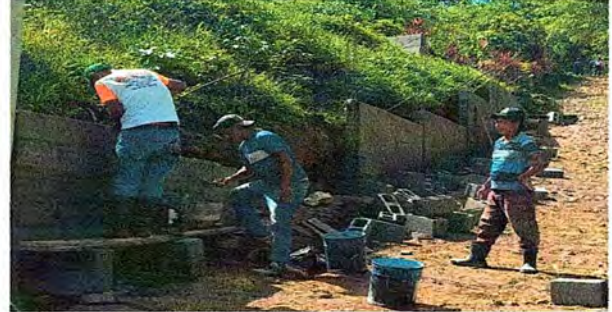
Foto 2: PROCESO DE COLOCACION DE BLOK
