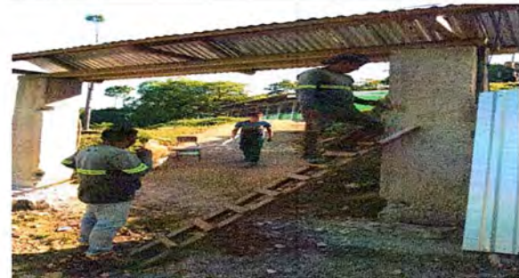
Foto 6: Proceso de instalacion porton
